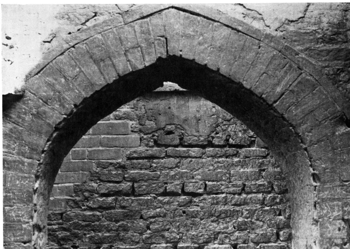
B. — Arc de la porte reliant les salles (g) et (e).
