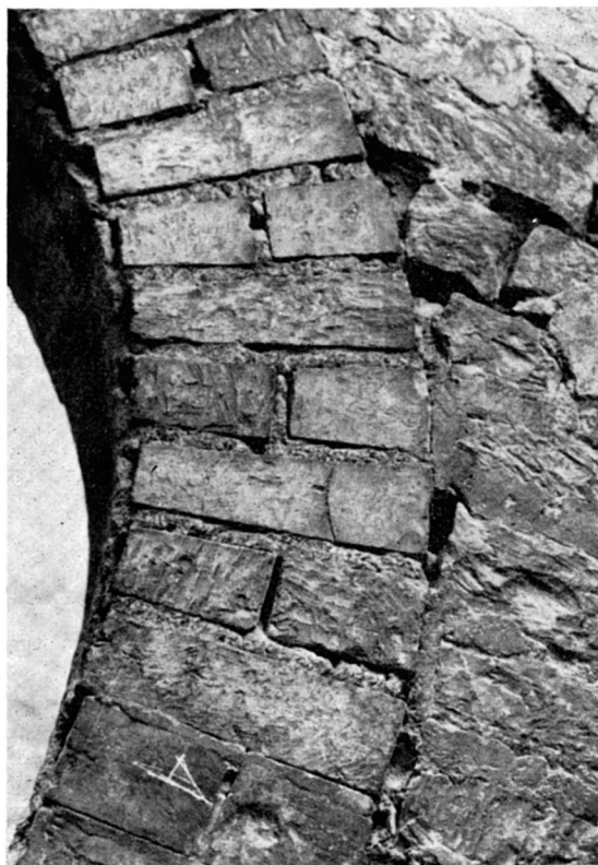
A. — Détail d'un arc de porte.
