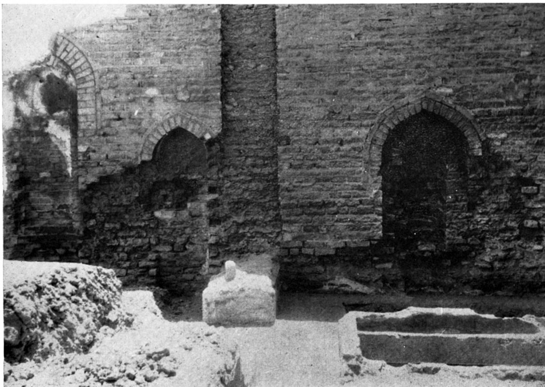
A. — Le triple mihrāb central avant restauration. (Photo du Service des Antiquités).
