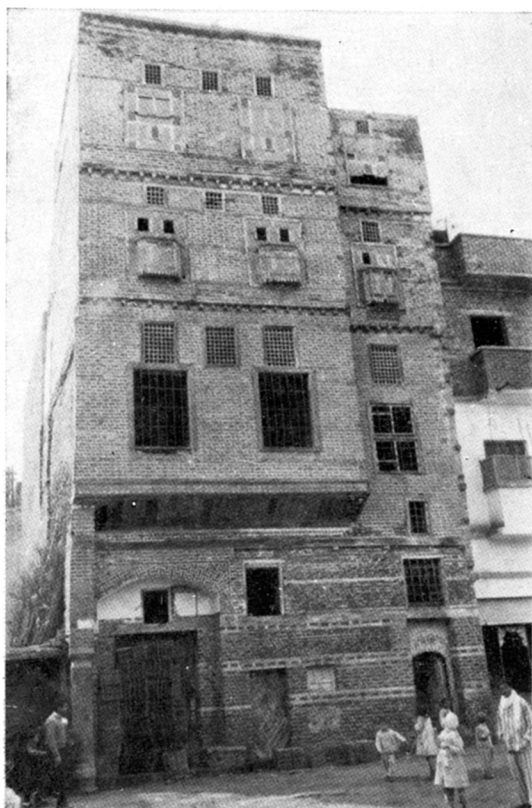
C. — Maison Farahat : façade.
