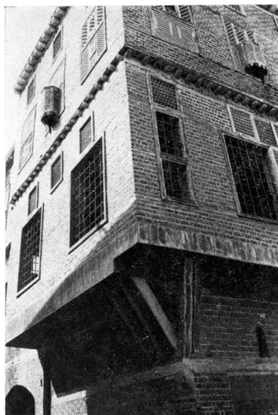
D. — Maison Bakrawali : façade.
