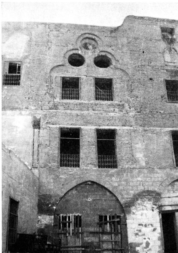
A. — Emir Taz : façade sur cour de la qa'a .
