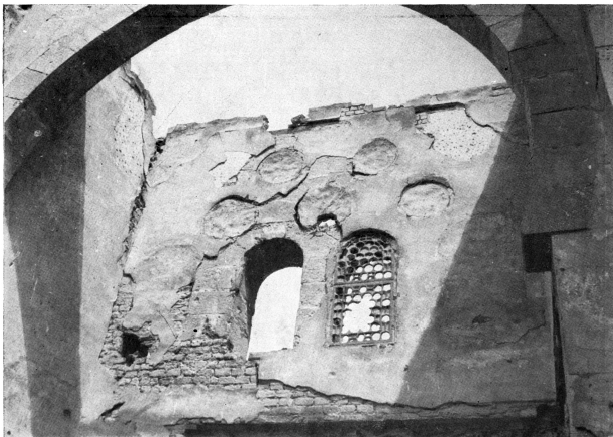
Qoussoun : armature en plâtre d'un vitrail.
