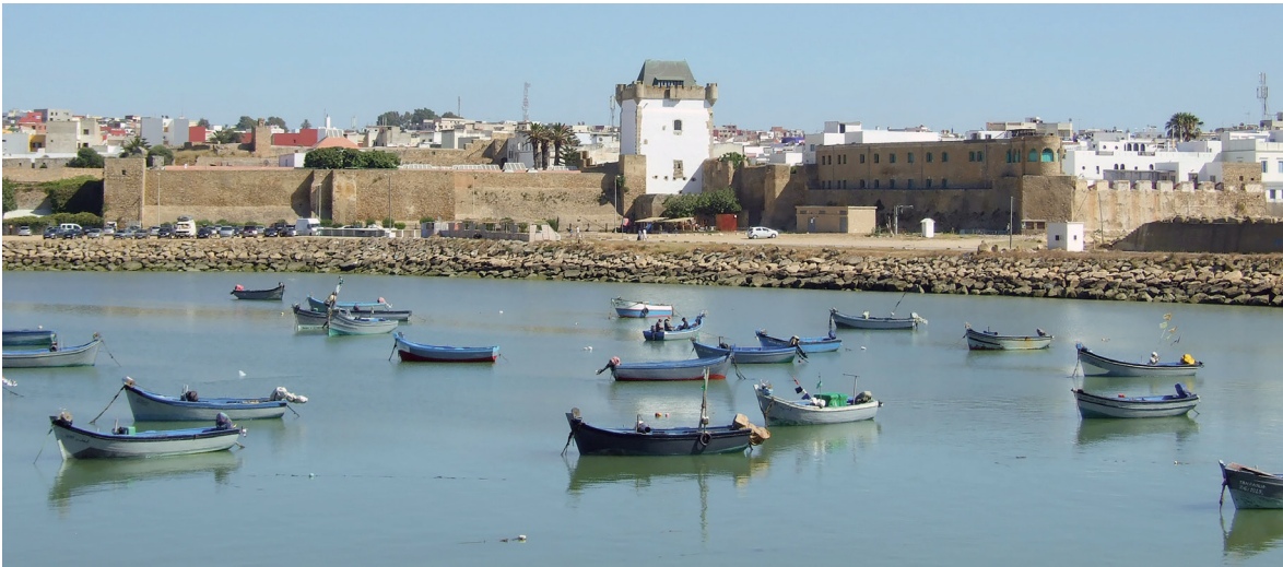
Fig. 6. Vue des remparts et donjon d'Asilah, depuis le port.
