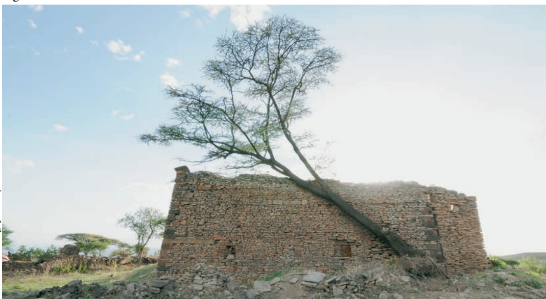
Fig. 5. Grande mosquée de Nora dans son environnement arbustif. (l'apparente déformation des murs est due à la prise de vue panoramique).
