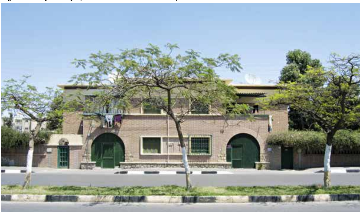
Fig. 17. Logements pour ouvriers indigènes, Ismaïlia, 1948, Henri Rauby, architecte. © Claudine Piaton, 2009.
