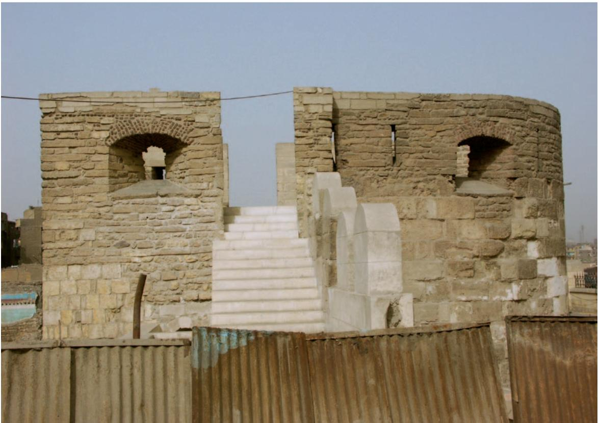
Planche 16. La tour d'angle n° 20 coiffée par des canonnères et des embrasures pour le tir au fusil.
