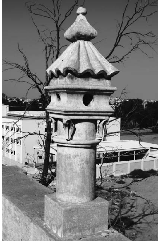
لوحة (٧). بيت الكاتب: الموقد، تفاصيل للمدخنة التي تعلو السطح العلوي.
