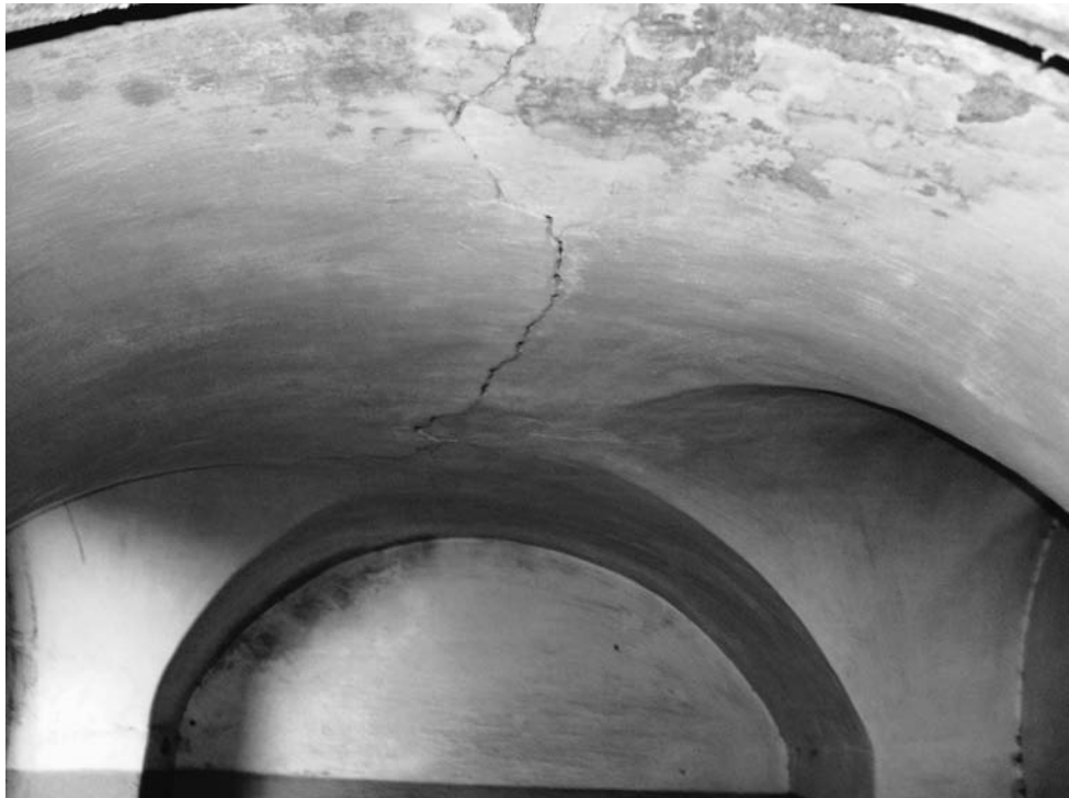
لوحة (٣). قصر بن سليمان بجبره: الطابق الأول، الحمام، القبو المتقاطع الذي يغطي الحجرة الساخنة.
