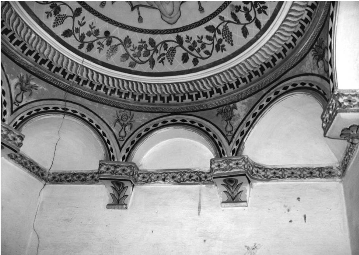
لوحة (١٦). بيت الكعكي: الطابق الأول، حمام الجناح الشمالي، الحجرة الساخنة، تفاصيل لمنطقة إنتقال القبة التي تغطيها.
