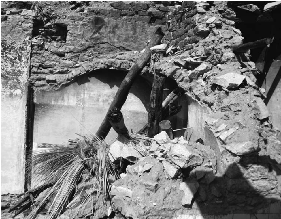
لوحة (٤). قصر بن سليمان بجبره: الطابق الأول، الحمام الشمالي، الحجرة الساخنة، ويلاحظ التغطية بقبو متقاطع والفرغ الذي يعلوه.
