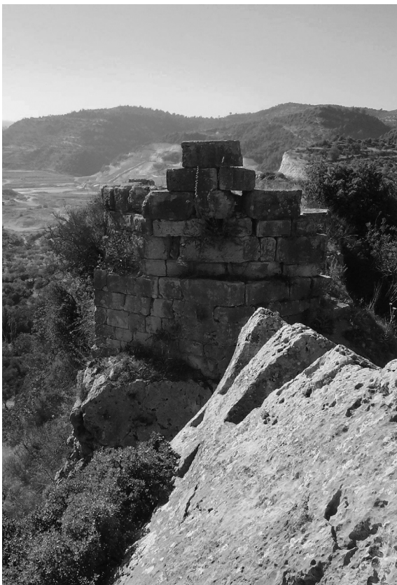
Fig. 17. Soubassements maçonnés et rupestres de la passerelle reliant les forteresses d’al-Šuġr et de Bakās à l’époque médiévale.
