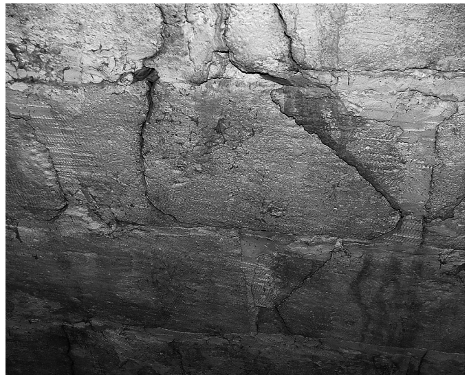
Fig. 27. Traces d'outils de ravalement intérieur, avec traces de gradine à dents.
