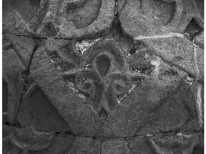
Fig. 25. Détail des vestiges de badigeon de chaux sur l'extrados de la coupole.
