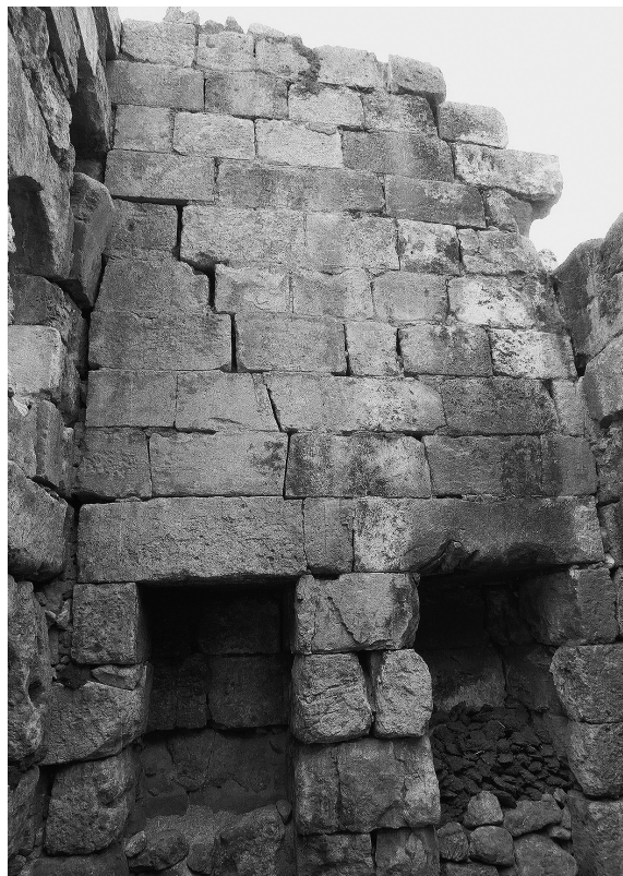
Fig. 46. Pièce 26, paroi sud.
