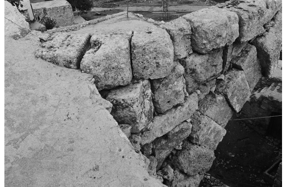
Fig. 40. Espace central, revers de l'angle nord-ouest.
