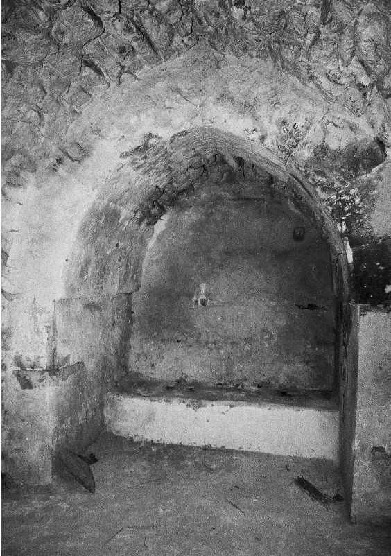
Fig. 50. Pièce 2, vue du haut du renforcement ouest (le sol actuel coupe en deux le volume primitif).
