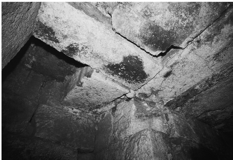
Fig. 57. Voûtement à la rencontre des couloirs 18 et 19.
