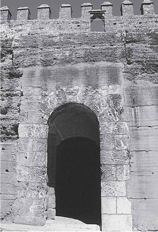
صورة ١١. لبلة. باب النجدة، الواجهة الداخلية.
