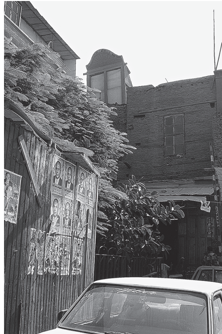
5.6. Malqaf au n° 67 rue Süq al-Silāh.
