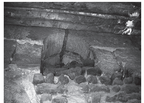
7.11. Conduit de ventilation nord.
