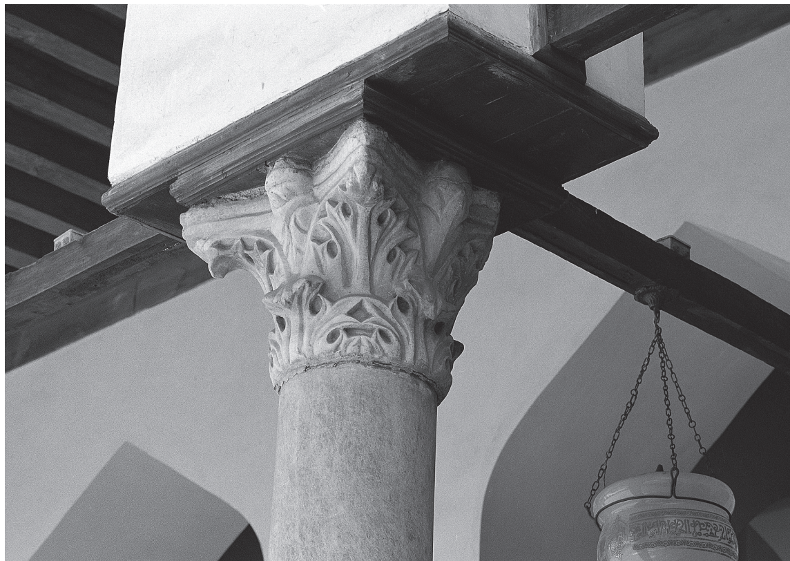
3. Type 3-A, chapiteau 13, corinthisant à deux couronnes de quatre feuilles; la couronne supérieure prend naissance au-dessus de la couronne inférieure.
