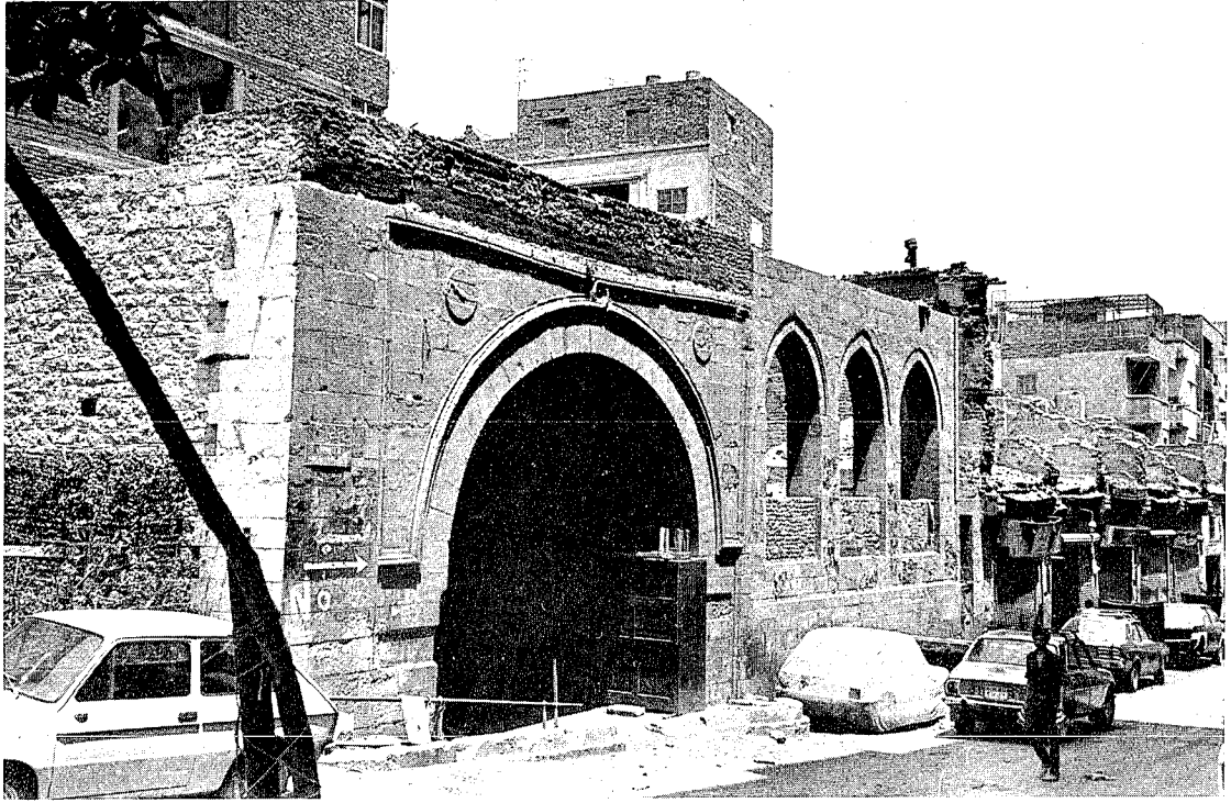
٤ - قصر الأمير منجك اليوسفي ، البوابة والحواصل المجاورة لها وبقايا الطبقتين بعد الترميم
