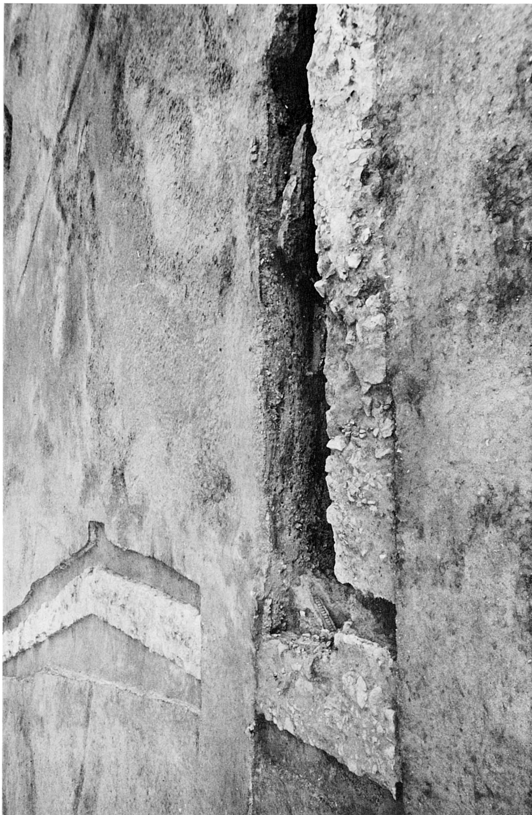
Vue de l'aqueduc près de la tranchée 2.
