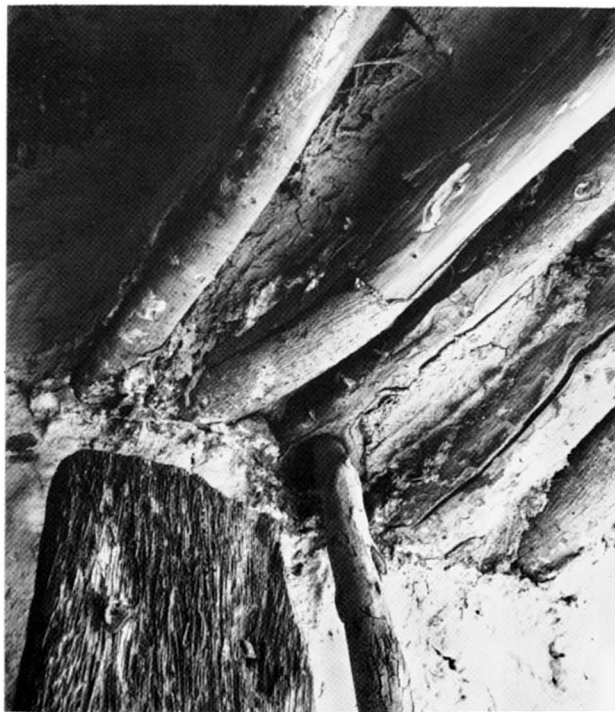
a — Fourche maintenant le pivot du vantail.
