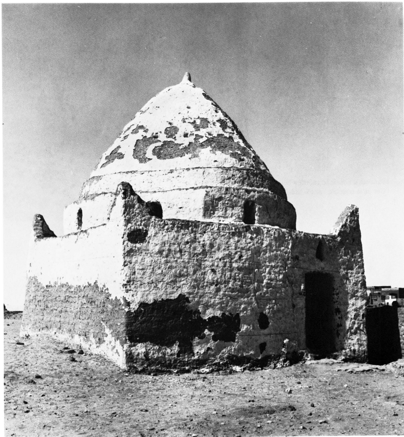
Vue générale prise du Sud-Est.
