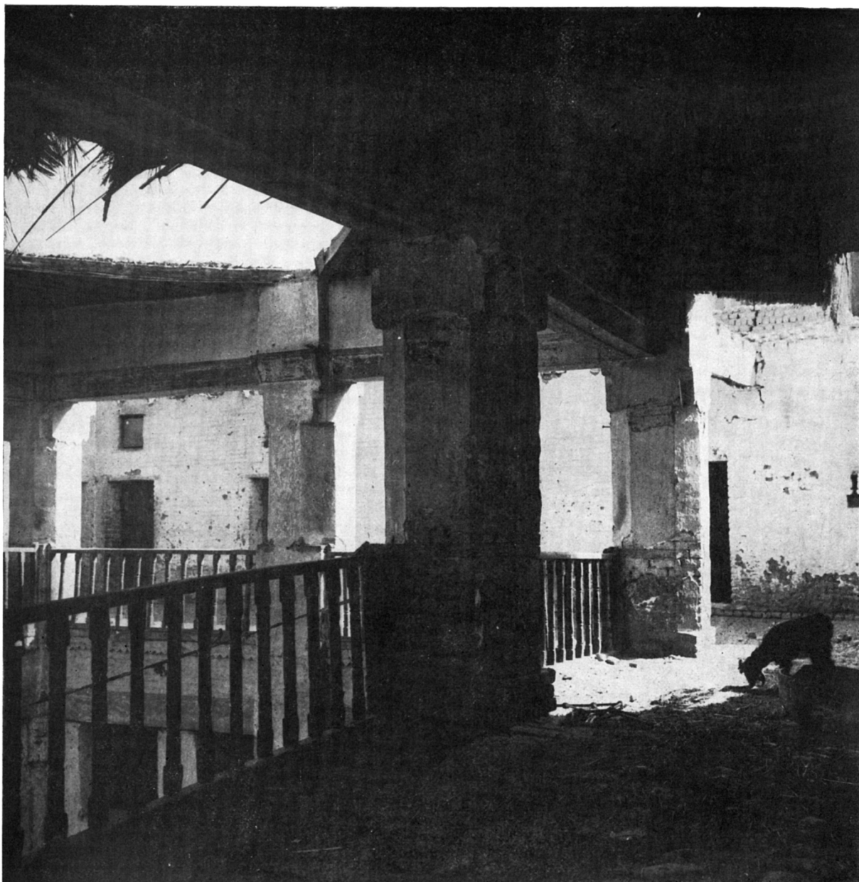
Galerie, vue générale.
