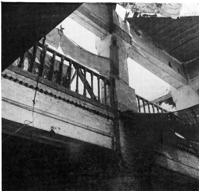
A. — Galerie vue de la cour.
