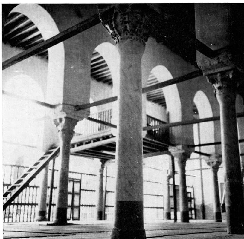
B. — Vue de la salle de prière.
