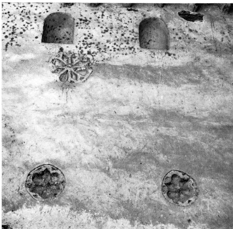
A. — Décoration du revêtement externe du mur Nord.
