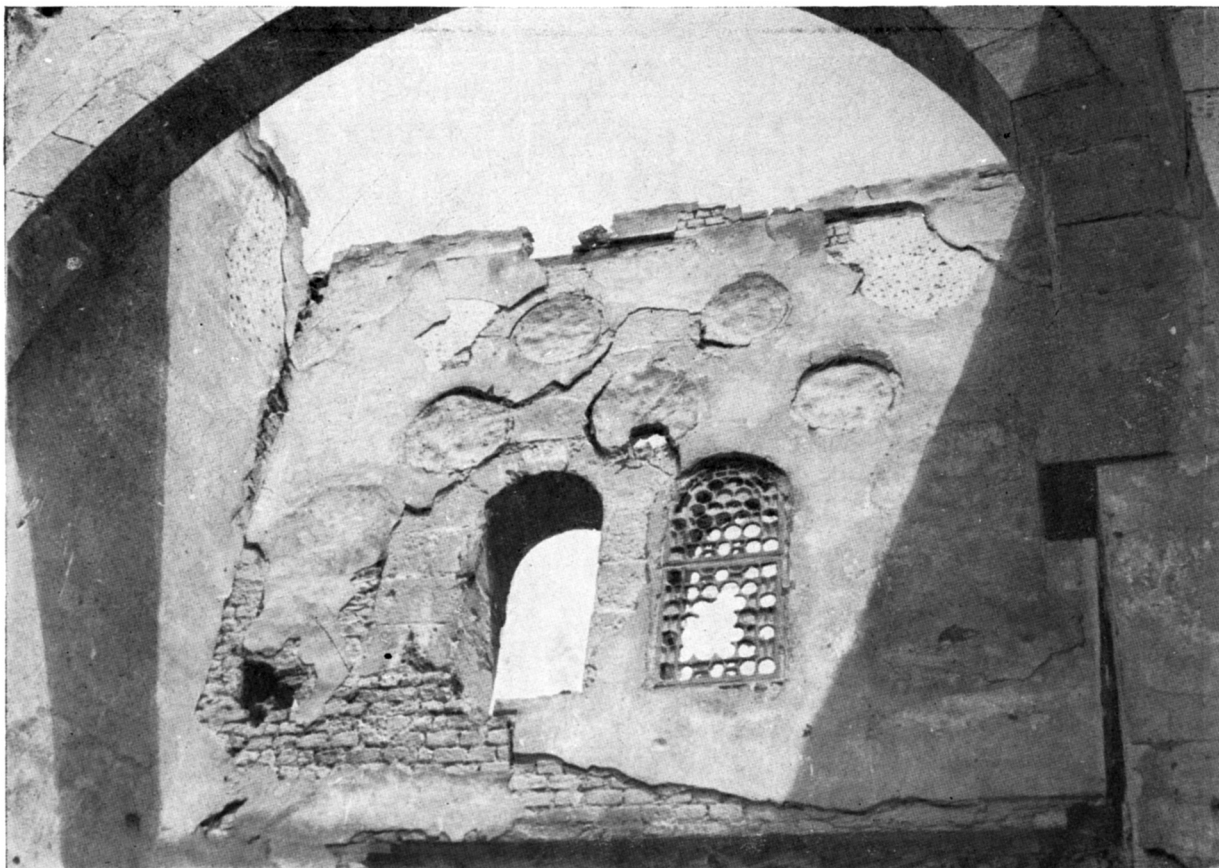
Qoussoun : armature en plâtre d'un vitrail.
