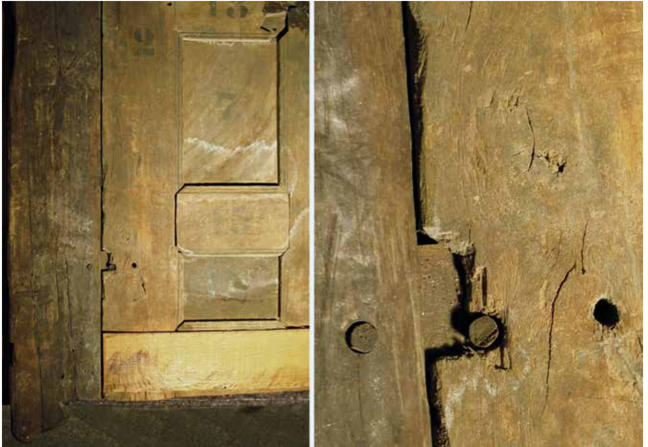
FIG. 6. Emplacement du faux-tenon (lacune dans le contreparement) et détail.
