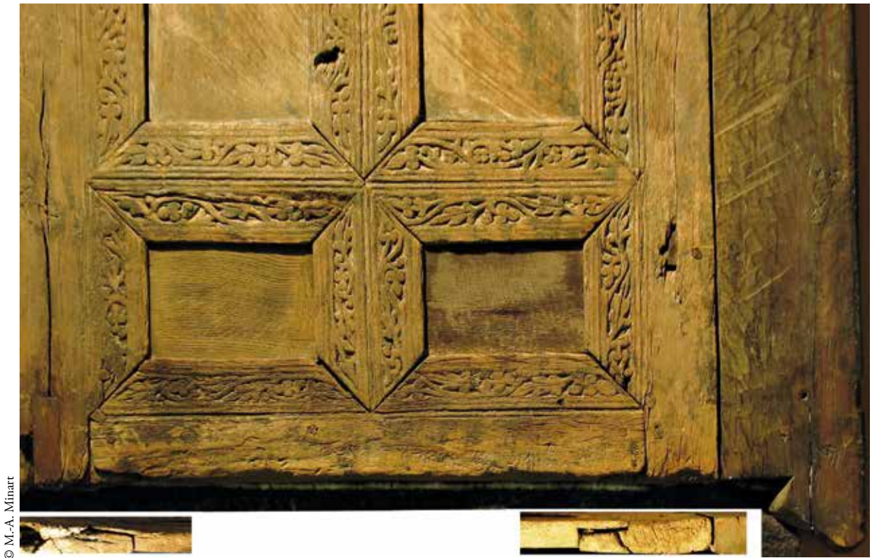
FIG. 16. Traces de sciage sur le chardonnet. Altérations fongiques de la base du battant.
