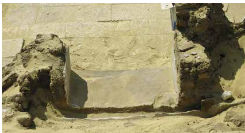
BIFAO 116 (2017), p. 279-272. Marie-Anne Minart, Dominique Bénazeth. Fig. 40. La porte d'accès au khurus en 2003; le seuil et la crapaudine. Vue vers le sud. Étude d'un vantail de la fin du premier millénaire conservé au musée du Louvre. Monastère de Baouît, Moyenne Égypte © IFAO 2026 BIFAO en ligne https://www.ifao.egnet.net
