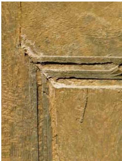
FIG. 18. Vue du contreparement, emplacement du faux-tenon médian entre le chardonnet et le montant 2, cassures, entaille trapézoïdale, perçages des axes de maintien des tenons-mortaises (le remontage est moderne, 1928), autres perçages, clou, chevilles/tourillons, zone de préhension ou de fermeture.
