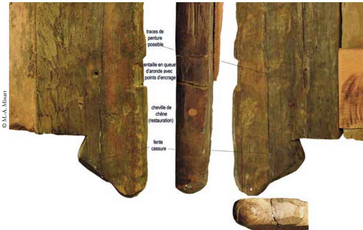
FIG. 7. Partie basse du chardonnet 1 : parement, chant, contreparement et dessous.
