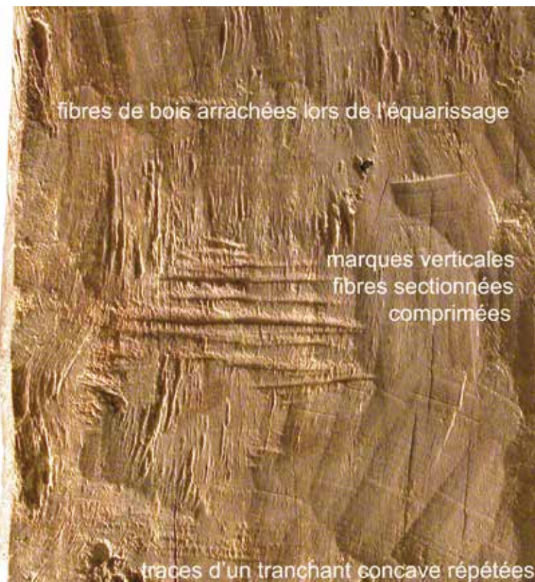
FIG. 31. Contreparement, détail du chardonnet 1.
