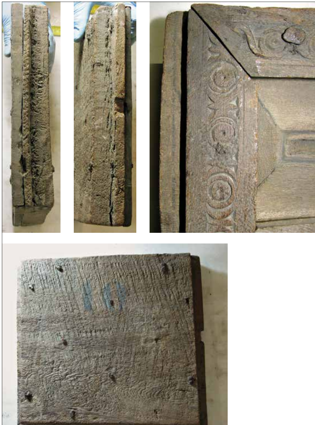
FIG. 12. Panneau 10, chants latéraux droit et gauche. Détail du parement : trait tout le long de la languette ; chanfrein à l'angle de la baguette supérieure pour limiter le ressaut sur le joint de la coupe d'onglet. Clous dépassant sur le contre-parement.
