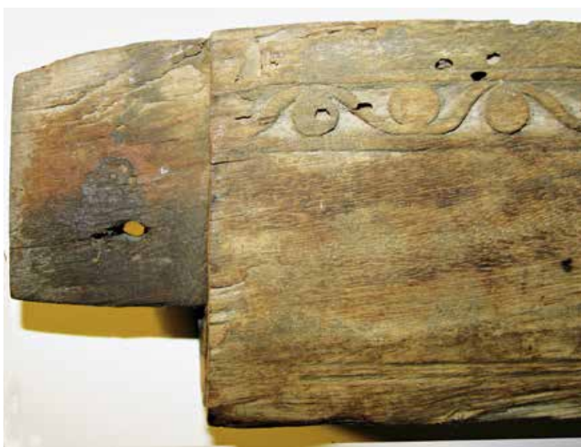
FIG. 6. Traverse inférieure 1: tenon à épaulement et détail du décor en façade.
