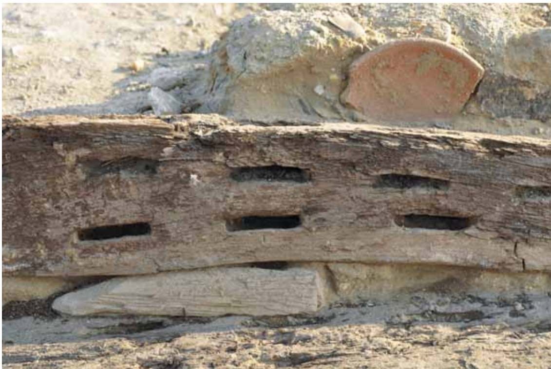
FIG. 19. Cheville de calage sous le bordage sud.
