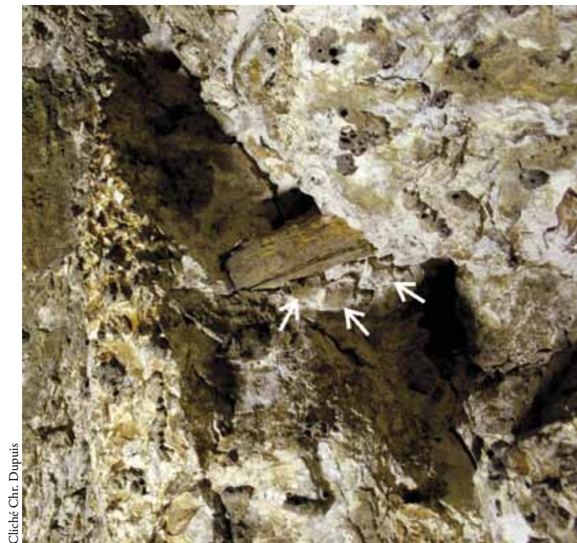
FIG. 22. Cale de bois dans une fracture ouverte du plafond de la deuxième salle de la TT 92. Seuls subsistent quelques éclats de calcaire (flèches) maçonnerie contre la pièce de bois, témoins d'un colmatage probablement complet de la fracture ouverte.
