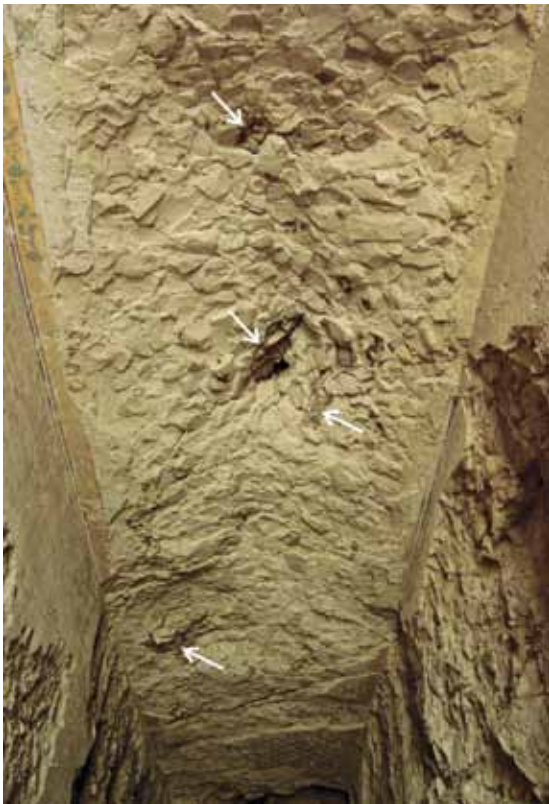
FIG. 13. Poche karstique perçant le plafond de la salle longue de la TT 71 (flèches) et réparation effectuée avec des éclats de calcaire maçonnés au plâtre.
