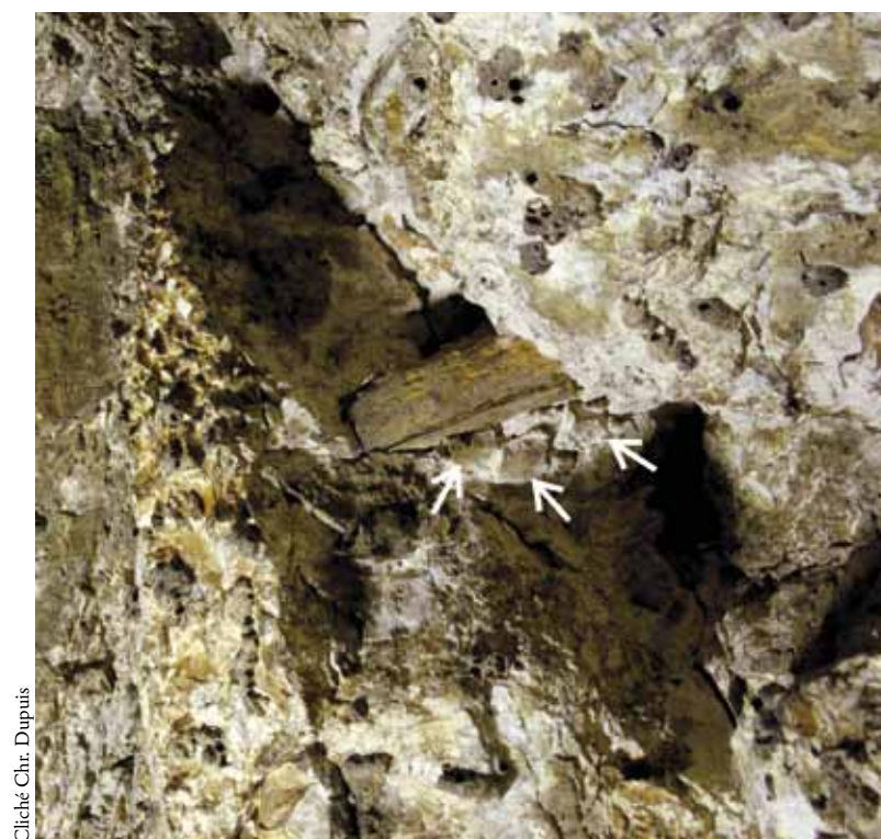
FIG. 22. Cale de bois dans une fracture ouverte du plafond de la deuxième salle de la TT 92. Seuls subsistent quelques éclats de calcaire (flèches) maçonnés contre la pièce de bois, témoins d'un colmatage probablement complet de la fracture ouverte.
