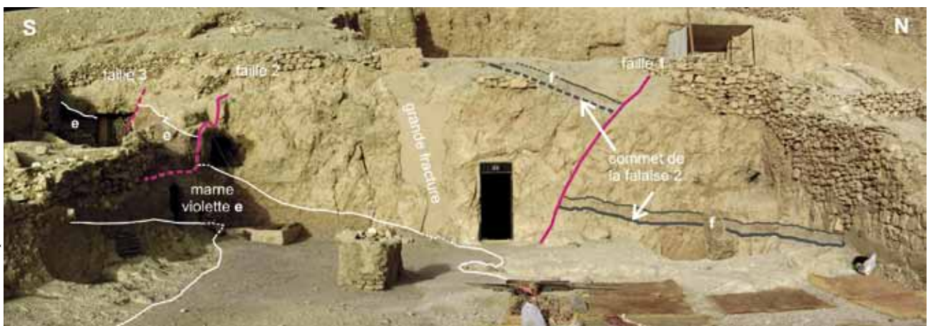
FIG. 11. Exemple de failles sur la façade de la TT 29.
