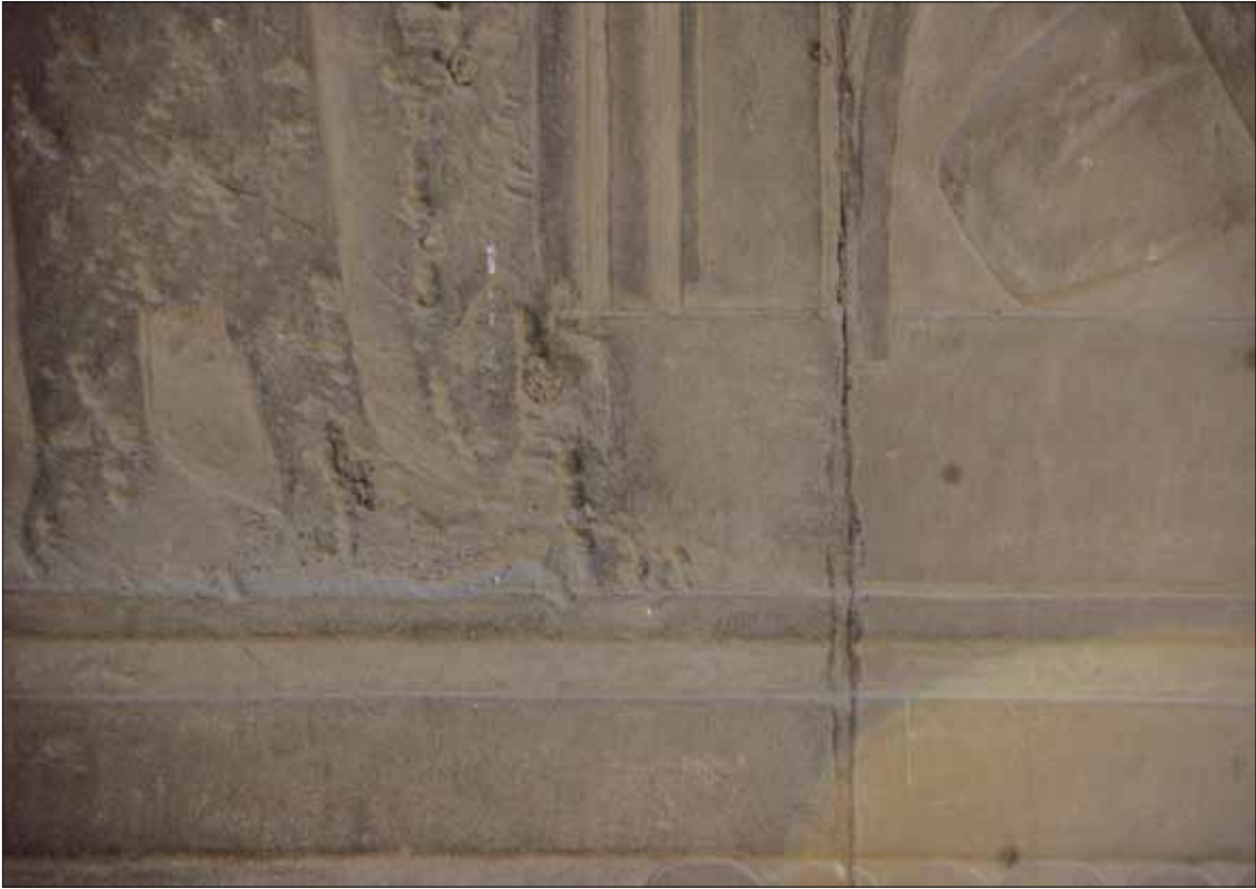
FIG. 6. Louxor, Salle V, deuxième registre est: restauration de l'estrade (photo R. Preys).
