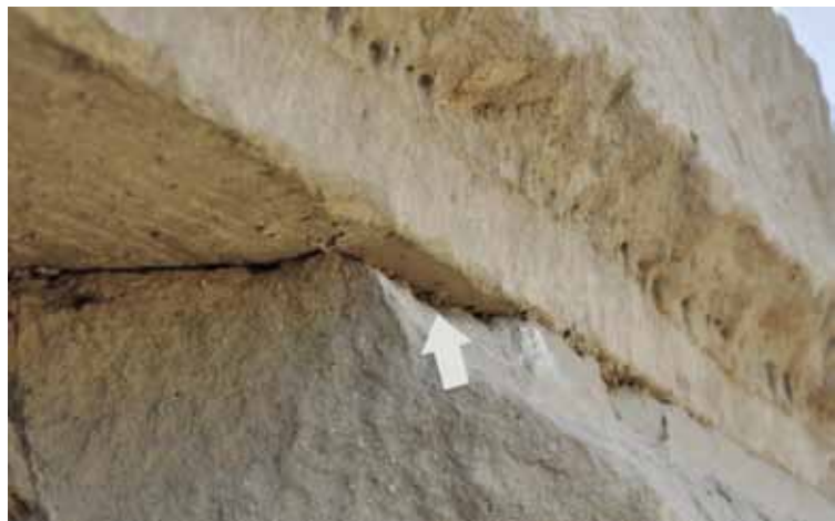
FIG. 11. Lit de pose partiellement visible sur la face nord du temple d'Opet. La zone égrisée en bordure du bloc en grès est un marqueur caractéristique du passage d'une scie.
