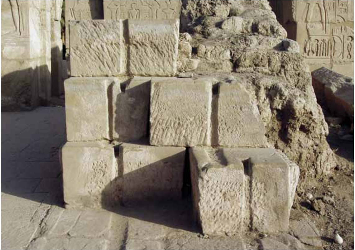
FIG. 5. Aménagement ptolémaïque (ou romain) au temple de l'Est à Karnak. Sur le bord des joints des blocs de gauche, que ce soit près de la face de parement ou du lit d'attente, les bandes égrissées consécutives au sciage sont bien visibles. Le coulis étant versé depuis le lit d'attente, les constructeurs ont ici pris soin de faire correspondre les canaux de coulée verticaux et horizontaux de manière à ce que le mortier se répartisse au plus profond de ces derniers.
