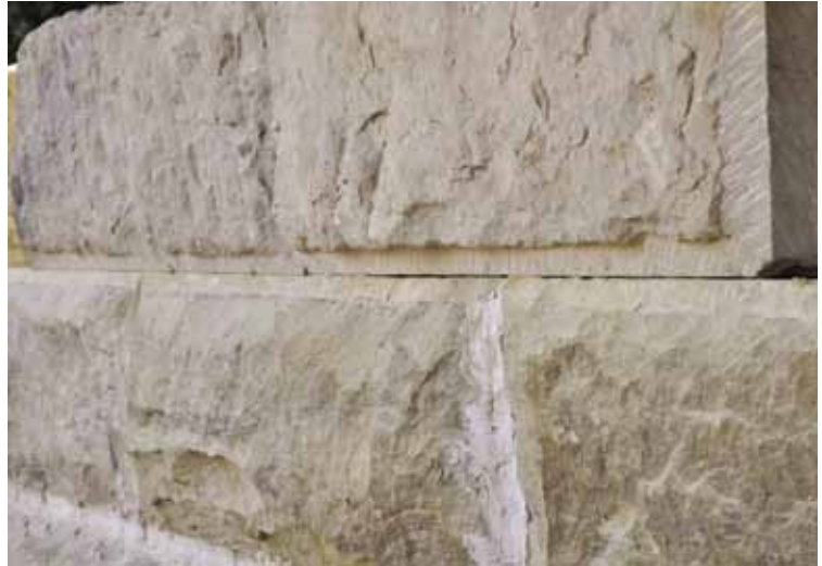
FIG. 21. Le joint horizontal avant l'ajustement par sciage.
