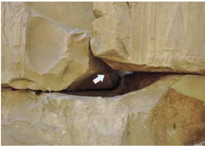
FIG. 13. « Coup de scie » laissé sur le joint vertical d'un bloc en calcaire du Netery-Menou. Ce détail prouve indiscutablement que le joint horizontal voisin a été scié.
