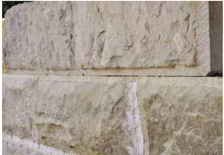
FIG. 21. Le joint horizontal avant l'ajustement par sciage.
