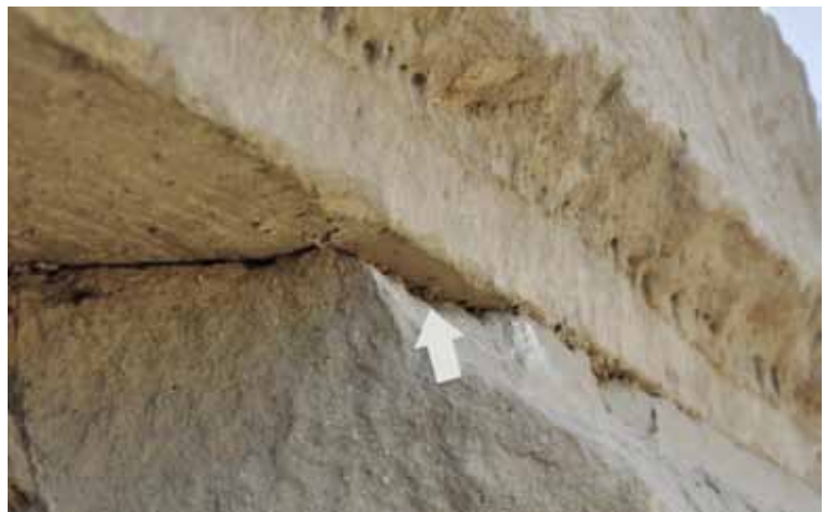
FIG. 11. Lit de pose partiellement visible sur la face nord du temple d'Opet. La zone égrisée en bordure du bloc en grès est un marqueur caractéristique du passage d'une scie.
