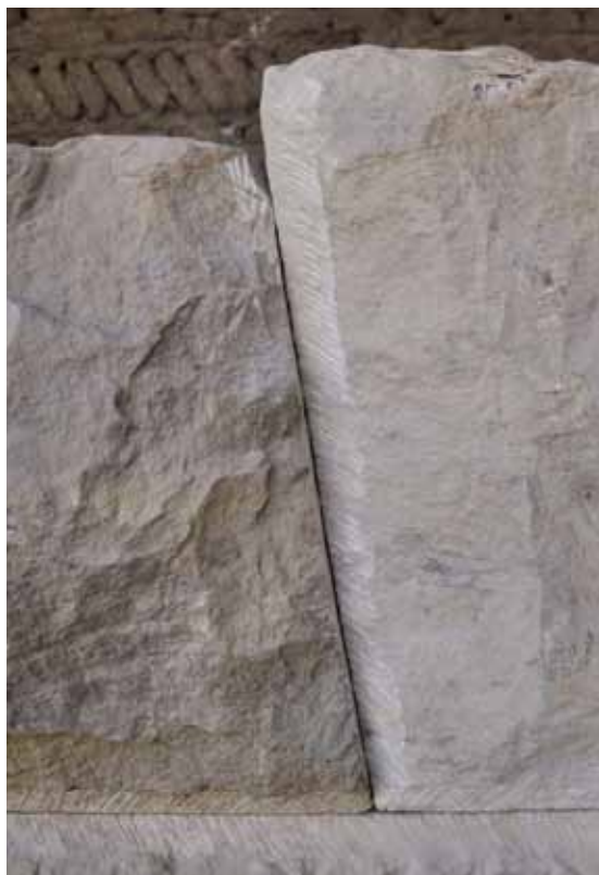
FIG. 18. État du joint avant l'ajustement par sciage.
