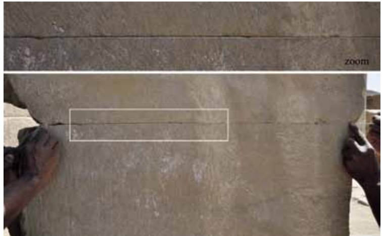
FIG. 9. Joint horizontal sinueux dans la maçonnerie du temple de l'Est à Karnak. Un fil blanc tendu met en évidence l'aspect non rectiligne du joint.
