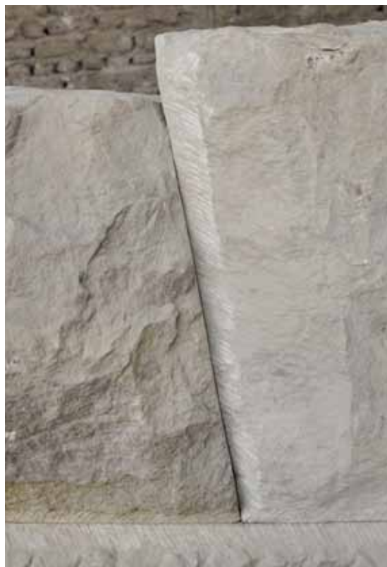
FIG. 20. Le joint après sciage et resserrement. Remarquer la petite trace de scie sur le lit d'attente, à la base du joint vertical, recouverte par le bloc de droite.
