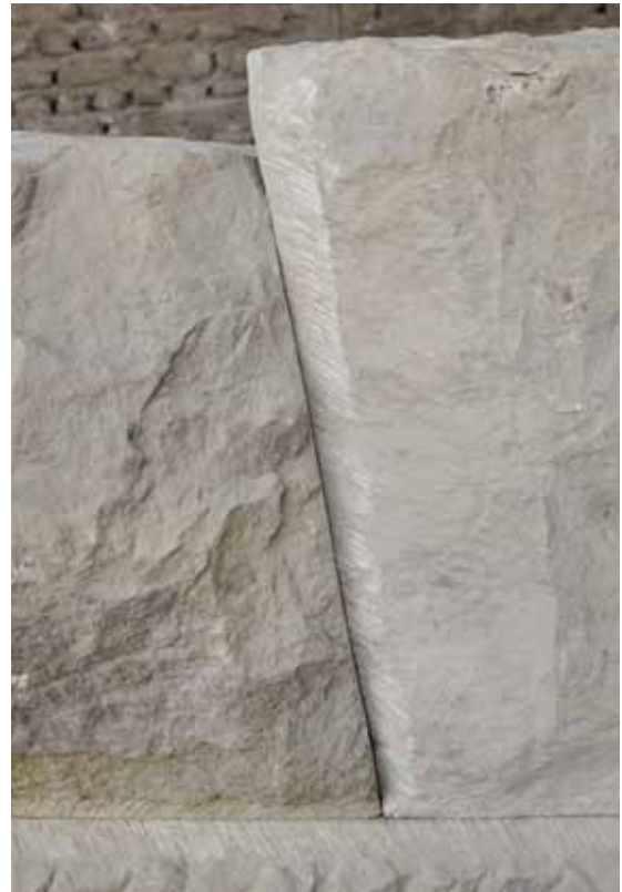
FIG. 20. Le joint après sciage et resserrement. Remarque la petite trace de scie sur le lit d'attente, à la base du joint vertical, recouverte par le bloc de droite.
