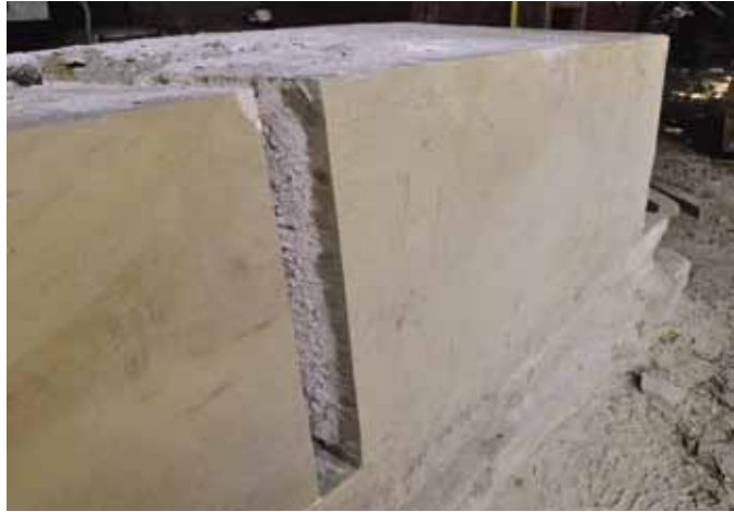
FIG. 28. Ouverture d'un joint montant pour observer la répartition du coulis. On constate que la propagation de celui-ci s'arrête à la limite de la zone sciée, là où le contact des faces de joint est parfait.
