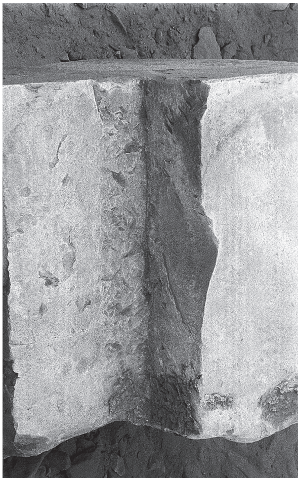
Photo 20. Bloc n° 14 : retaille de la feuillure verticale.
