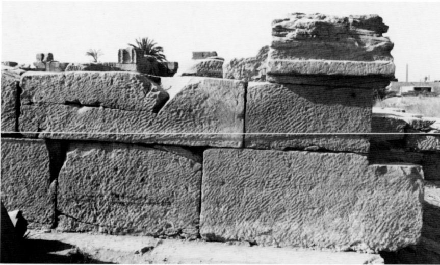
◁ A. Podium, premier état, face nord, extrémité ouest : dévers des assises corrigé lors de la taille de la corniche (la corde indique l'horizontale).
