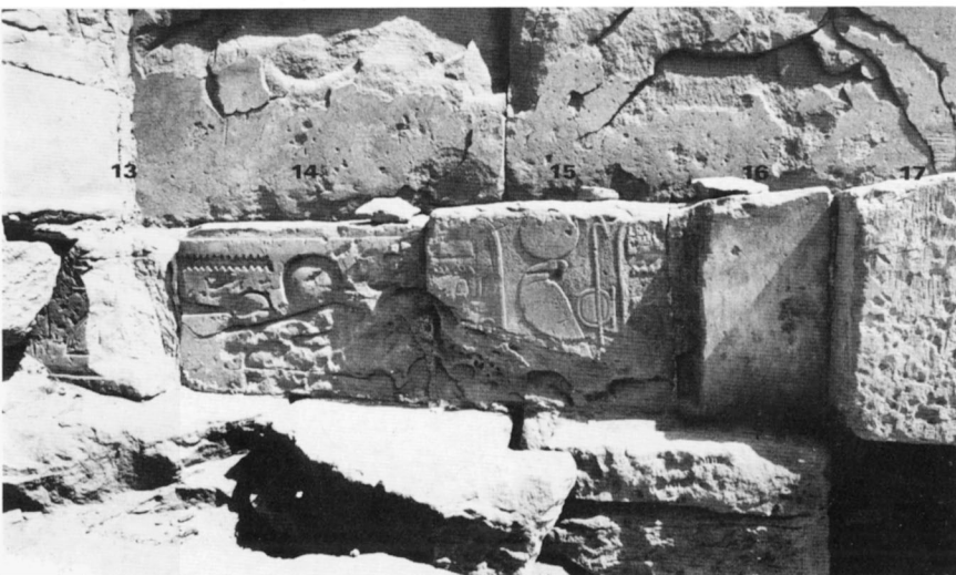
◁ C. Blocs au nom d'Aménophis III remployés en fondation du mur est, n os 13 à 17.
