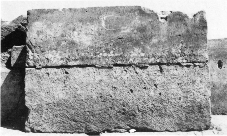
◁ A. Pile de support de l'architrave est en façade du péristyle.
