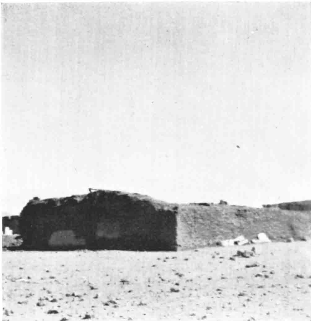
A. Angle extérieur Sud-Ouest du sanatorium.
