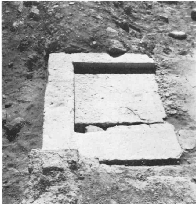
B. Le seuil Est du couloir bétonné.
