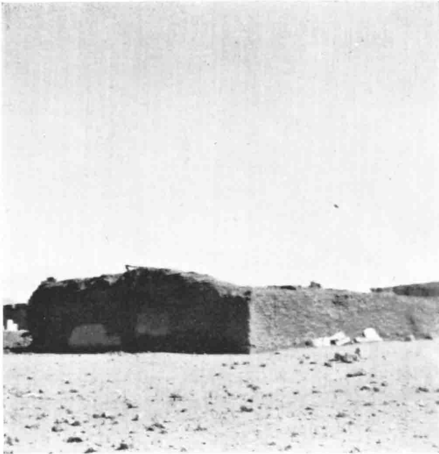
A. Angle extérieur Sud-Ouest du sanatorium.
