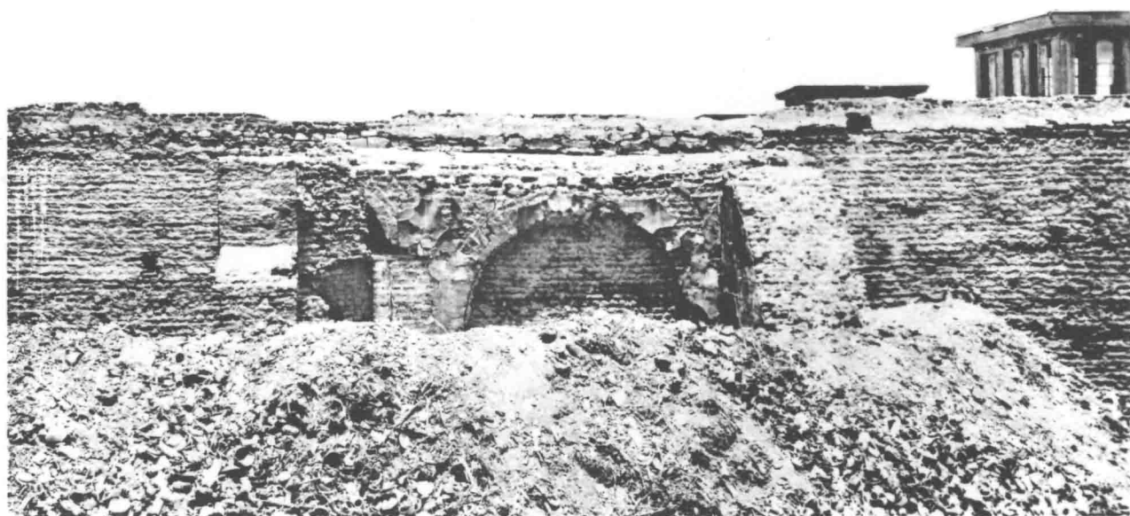
La mosquée de 'Amru : façade S.-O., restes d'un panneau.
