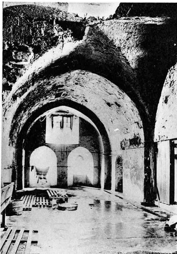
A. — Burg Kerkyalân : interior, looking east.
