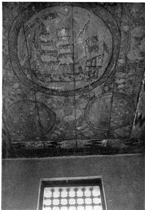
A. — Maison Mandili : plafond peint.
